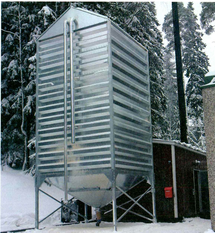
Laittekontti painaa noin 13 tonnia. Se tuotiin paikalle lavettikuljetuksena. Kokonaisuuteen kuuluu 52 kuution vetoinen pellettsilo, joka riittää pariksi viikoksi pikkupakkasilla.
