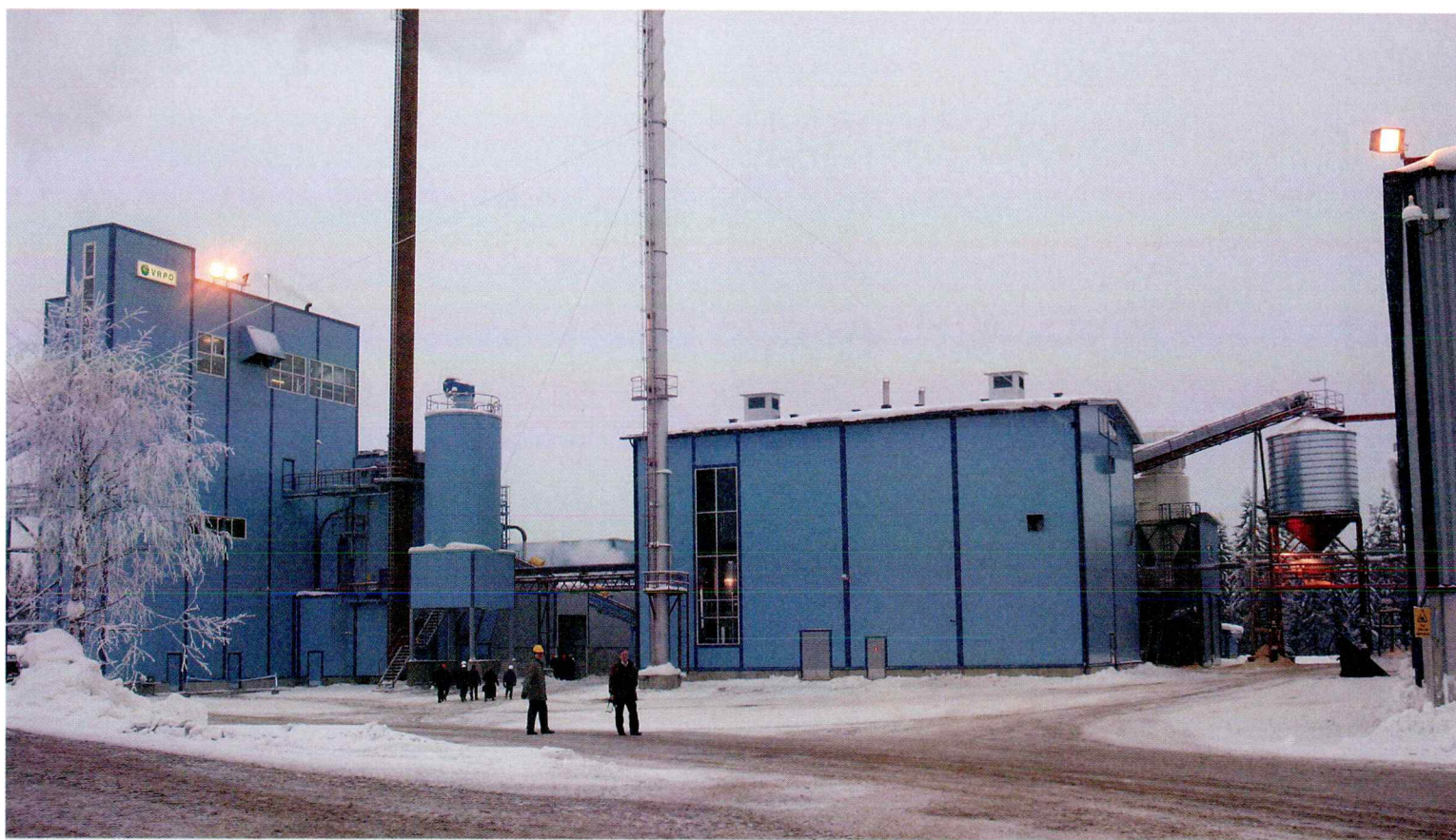
Voimalan (vas.) kattilan polttoaineena käytetään metsähaketta ja jyrshinturvetta, josta tuotetaan Ilomantsin kaukolämpöverkkoon 8 ja tehtaan prosessihöyryn tuotantoon reilun 7 megawatin teho. Polttoainetta tarvitaan suunnilleen 1 400 rekka-autokuormaa vuodessa.
