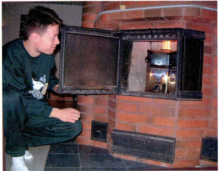
Polttokori antaa hyvän mahdollisuuden käyttää puupellettejä tulisijassa silloin, kun puita ei ole saatavilla, niiden varastointi on vaikeaa tai puista irtoavat roskat häiritsevät. Tulipiipun kori mahtuu korkeaan tilaan.
