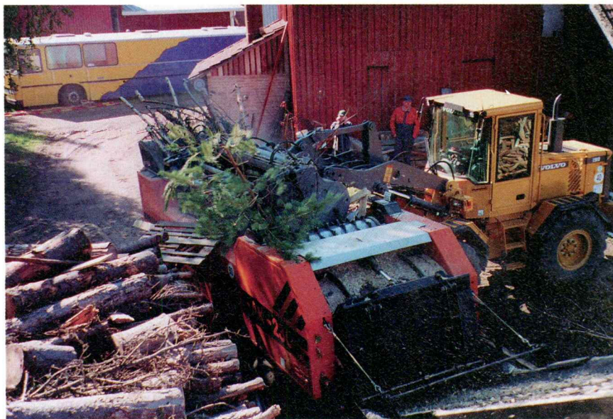
Laudanpätäkät ja kertakäyttökuormalavat menivät sujuvasti murskaimeen. Pitkä risutavara sen sijaan vaati enemmän työtä kuormaajan kauhalla, jotta syöttörulla sai otteen risuista. Muut murskattavat olivat purkupuuta, kantoja sekä lumppeja.
