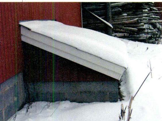
Tankopurkaimen hydraulisylinterit ovat omassa suojassaan. Myös siellä on lattialämmitys.
