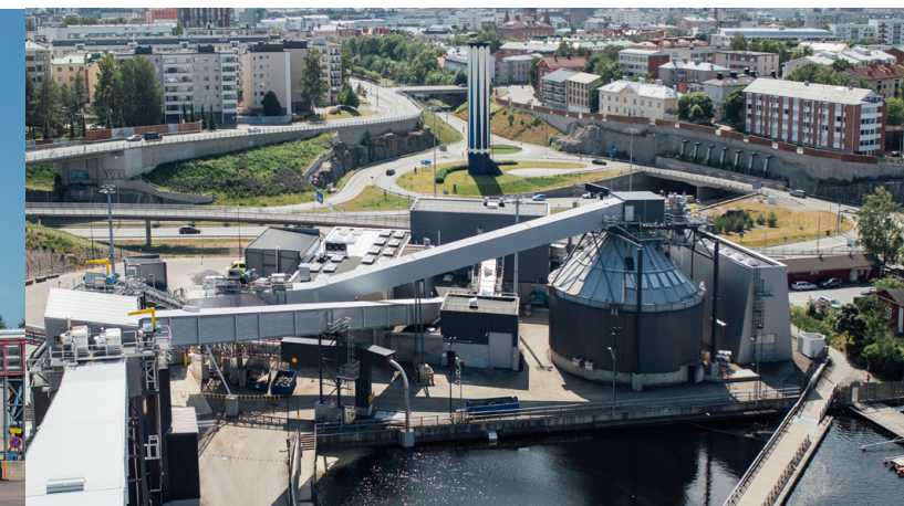
Laitos sijaitsee aivan kaupungin kulutuskeskittymän äärellä. Tiiviillä tontilla riittää kuhinaa, kun päivässä polttoainetta laitokselle tuo 50–60 ajoneuvoyhdistelmää.
