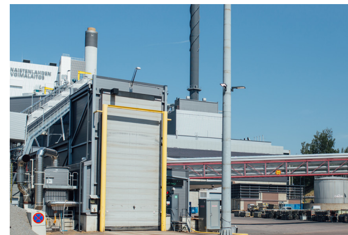
Polttoaineiden purkupaikkoja on kaksi, joista toinen on kokonaan uusi.
