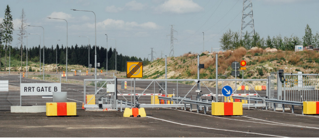
Alue on vartioitu ja valaistu.
