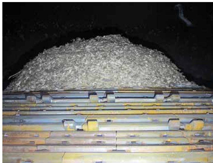
↑ KPA Uniconin toinen pyörivän arinan kattila odottaa kylmeneviä säitä. Toisessa kattilassa on jo tulet.
