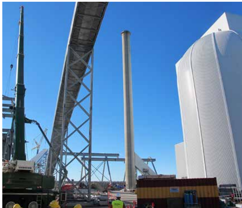
↑ Skaerbeckin satamaan rakennetaan 9 vuorokauden täystuotannon avonainen varastosilo, jolla on pohjapurku. Sen reunat näkyvät takana alhaalla kuljettimien alla. Puu ostetaan valtaosin FOB:ina, eli myyjän satamaan toimittamana ja lastattuna.
