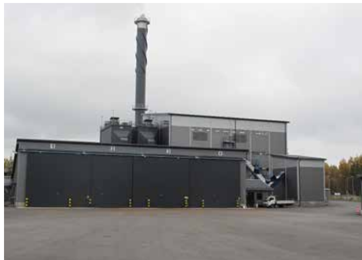
Imatran Lämpö Oy:n uudessa laitoksessa on kaksi KPA Uniconin kattilaa.
