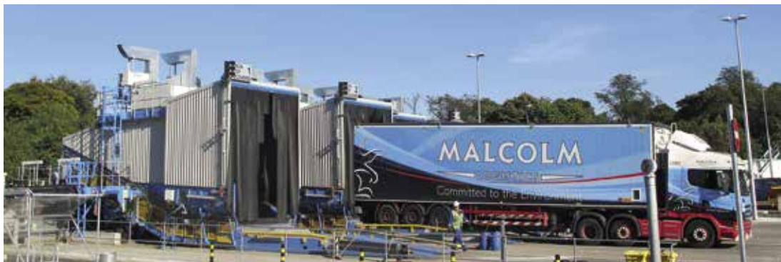
↑ Prosessoitu käytetty puu puretaan peräpurkuvaunuista kahteen taskuun.
