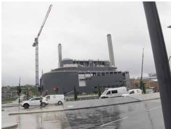
↑ Moottoritie kulkee vieressä. Vielä muutama vuosi sitten suunnitel- teilla ei ollut maantiekuljetuksia, mutta nyt ne ovat mukana suunnitel- missa. Puuta on tarjolla hyvin, enemmän kuin osattiin odottaakaan.
