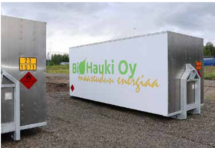
↑ Puhdistettu liikennekaasu paineistetaan pullokontteihin. Kontissa kaasua voidaan siirtää kätevästi myös muualle.
