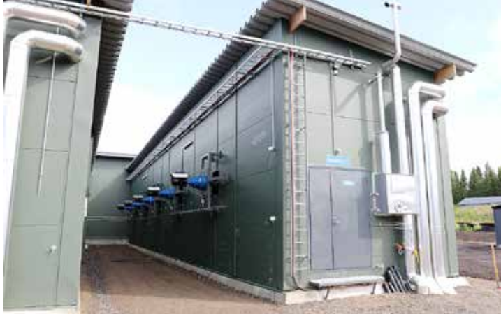
↑ Mädätysreaktorit ovat jatkuvatoimisia. Laitoksessa on kaksi reaktoria ja lisäksi pihalla on varaus kahdelle lisäreaktorille.
