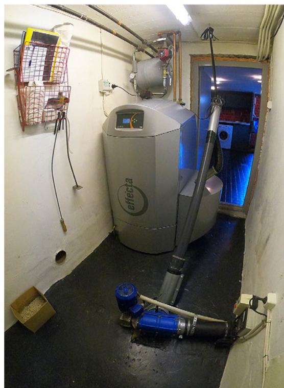
↑ Uudelle pellettikattilalle ja siirtojärjestelmälle rakennettiin tila siilon viereen.
