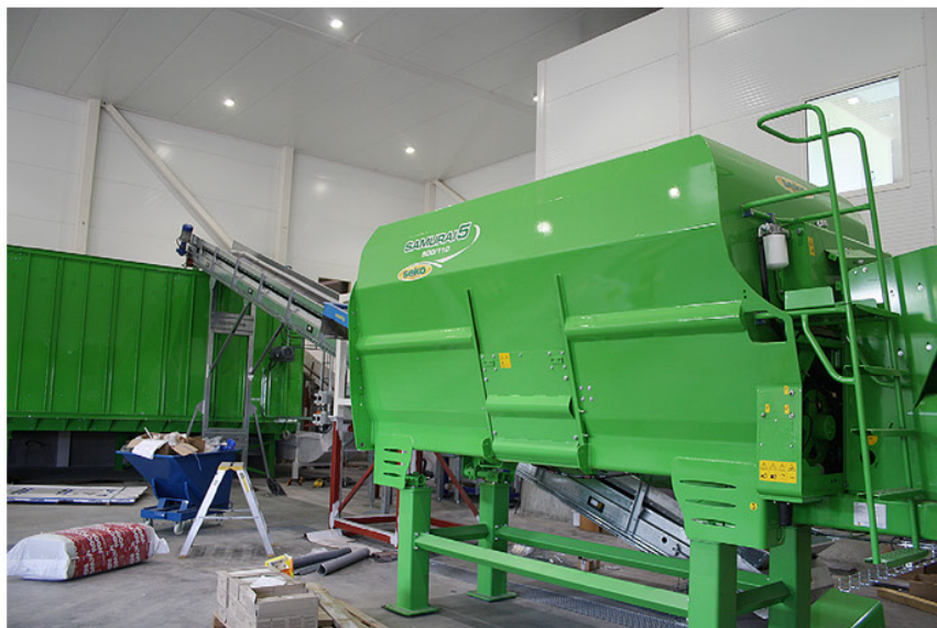
↑ Korsirehun kohdalla esikäsitellyllä on iso merkitys. Sitä varten on automaattinen murskausvaunu.
