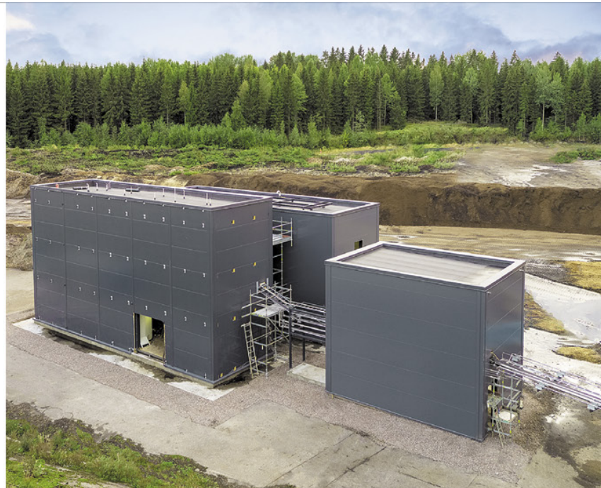
↑ C-Green Technology on rakentanut Stora Enson Heinolan kartonkitehtaan yhteyteen biohiiltä tuottavan laitoksen. Yksikkö on jo käynnissä. Kuva: C-Green Technology AB
