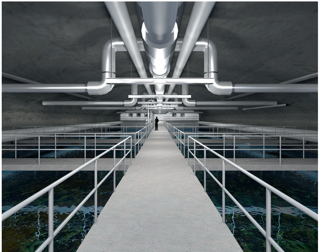
↑ Biologisessa osassa viljellään aktiivilietettä, jonka mikrobikanta on säädeltyä ja poistaa orgaanista ainesta. Syvien (12 m vettä) ilmastusaltaiden tilavuus on 15 000 m 3 .
