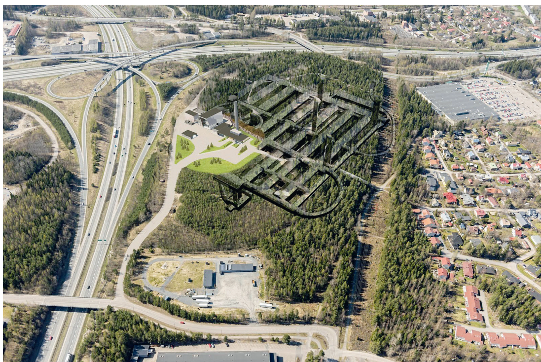
↑ Tämä yli 300 miljoonan euron jättihanke sisältää käytännössä kaksi osaa: itse puhdistamon ja siirtovie-märit, jotka siirtävät jätevedet kunnallisista viemäreistä Sulkavuoreen puhdistettavaksi.
