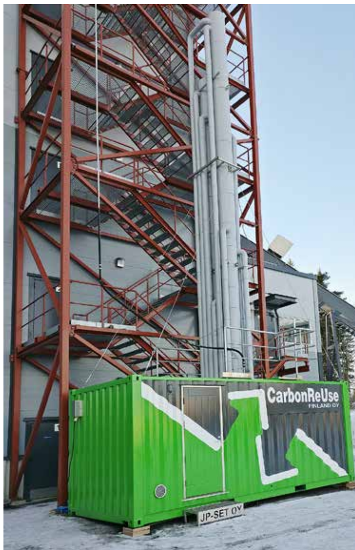
↑ Savonlinnalaisen CarbonReUse Finland Oy:n hiilidioksidin talteenotto-prosessin pilottilaitte perustuu puhtaan veden käyttöön teollisessa mitassa.
