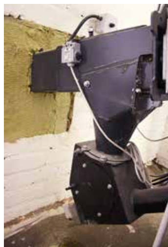
↑ Pudotussuppilo ja sulkuläppä huolehtivat paloturvallisuudesta.
