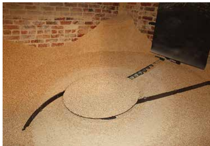
↑ Siiloon mahtuu noin 8 tonnia pellettiä kerrallaan – pellettiä kuluu noin 16 tonnia vuodessa. Suoraan lattialle on asennettu hyväksi havaittu jousipurkain.
