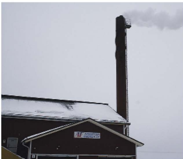
↑ Termopointin kattila on pyörinyt vuodesta 2006.
