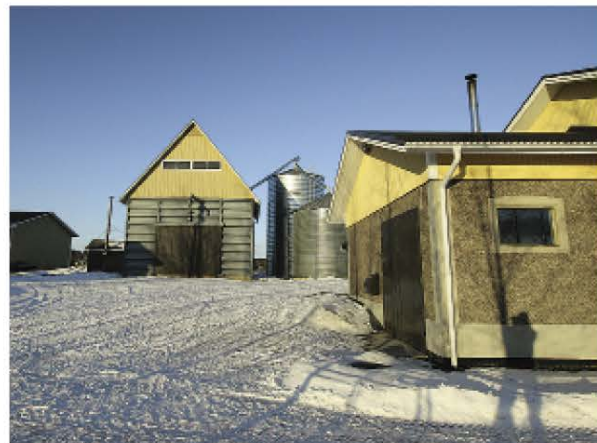
↑ Kuivuri ja korjaamo ovat hyvin lähellä kuvan oikeassa reunassa näkyvää hakeämpökeskusta.
