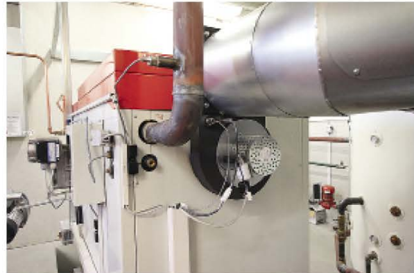
↑ Savukaasumuri säättää kattilan alipaineen aina tasaiseksi.
