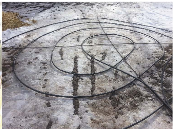
↑ Täyttämisen aikana huolehditaan 32 mm vesijohdon asentamisesta.
