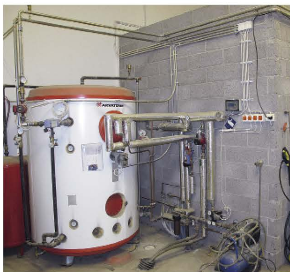
↑ Lämpöakku parantaa kattilan hyötysuhdetta ja mahdollistaa hybridijärjestelmän täysimääräistä käyttöä ympäri vuoden.
