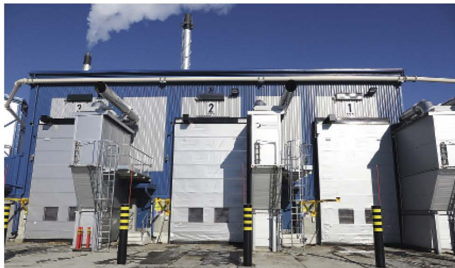
↑ Kolmipaikkainen, läpiajettava vastaanottoasema tuo tehoa vastaanottoon, joka liian monessa paikassa on pullonkaula ja piilokustannus.
