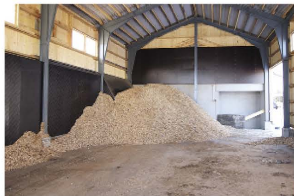
↑ Hakevarastoon mahtuu vuoden tarve hakeita. Tankopurkain on takanurkassa hakekasan alla. Oikeaan nurkkaan tulee esipuhdistusjätteille oma sillo, josta sitä syötetään omalla ruuvilla järjestelmään.
