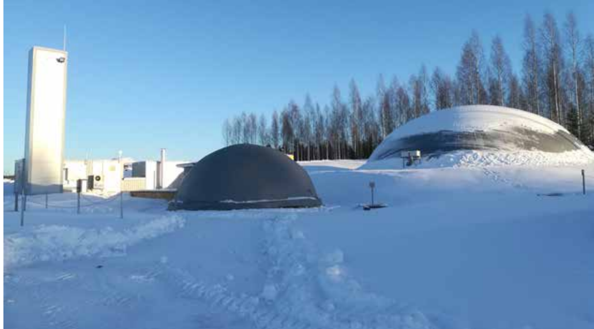
↑ Palopuron Biokaasu oy:n kuivamädätyslaitos Hyvinkäällä. Pääomistaja Nivos Energia oy ja laitostuottaja Metener oy. Kuva: Elina Virkkunen (Luke)
