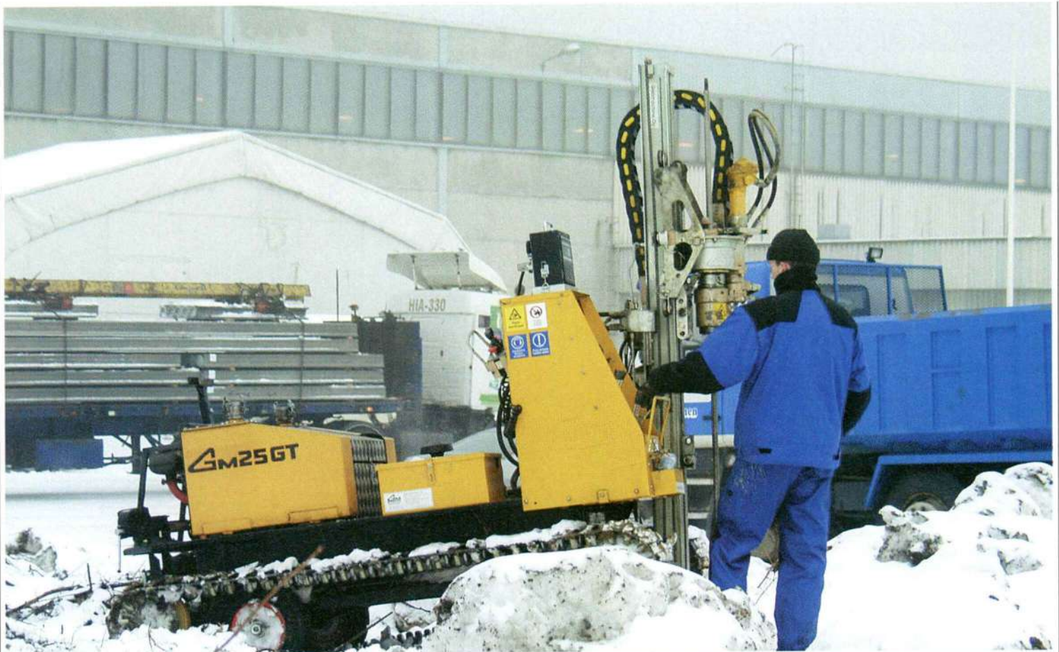
Parman hakelämpökeskuksen tontin maaperätutkimukset olivat käynnissä jo tammikuussa.
