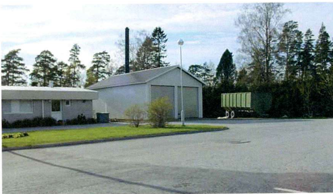
Kuortaaneella vanhainkodin pihassa on autotallin näköinen rakennus, jossa on 700 kW:n aluelämpökeskus.
